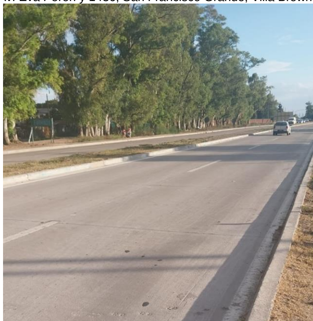
Foto 33 Obra de ampliación Ruta Provincial N°53 Av. Eva Perón y 1436, San Francisco Grande, Villa Brown
